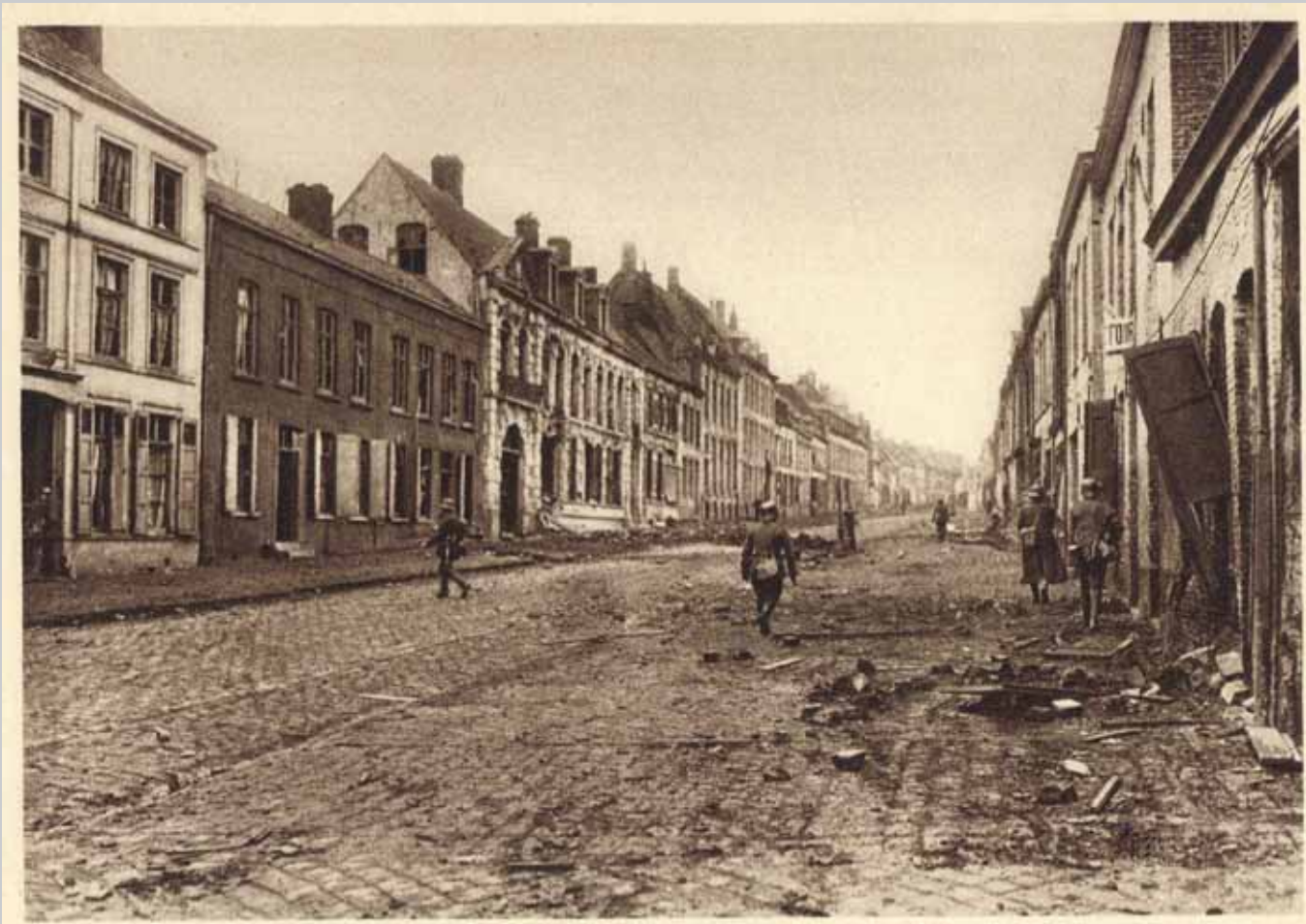
Im gefürhten Neuveville. Abfaden der Häufer nach verprengten Feinden. Bei Kriegsbeginn waren die Verluße, die unferen Gruppen durch verfeidete Feinde zugefügt wurden, sehr erheblich. Man richtete daher feildem ein befonderes Augenmerk auf eine reifliche Säuberung der genommenen Orte, ehe größere Formationen den Ort befchritten.
