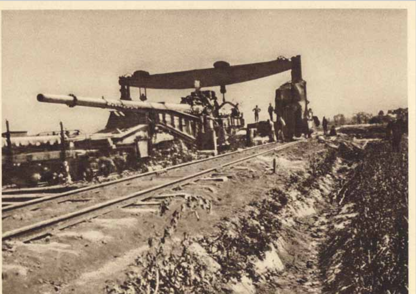
Das fagenunwobene Kiefenbüchfe, das vom Raoner Abfchnitt aus 128 km Entfernung Paris wirffam befchoß. Es handelt fih um eine Zufammenfegung aus 88 cm und 21 cm Gefchüßen mit infianenbergelagerten Rohren. Um eine Entdeckung des Gefchüßes durch den Feind zu verhüten, wurde die ganze Gegend vernebelt, ferner gelangten zahlreiche andere Gefchüße gleichzeilig zum Abfchuß. Die beiden Rohrverlängerungsröhren (je 12 m) wurden durch einen mitgeführten Kran auf das Rohr gefeßt. Die gefamte Rohrlänge belief fih auf 34 m, das Gefamtschwermet auf 140 Tonnen. Ursprünglich war das Gefchüß bei Raon (128 km) aufgefellt, dann bei Beaumont (109 km) und ab 16. Juli 1918 bei Chateau-Thierry (87 km).
